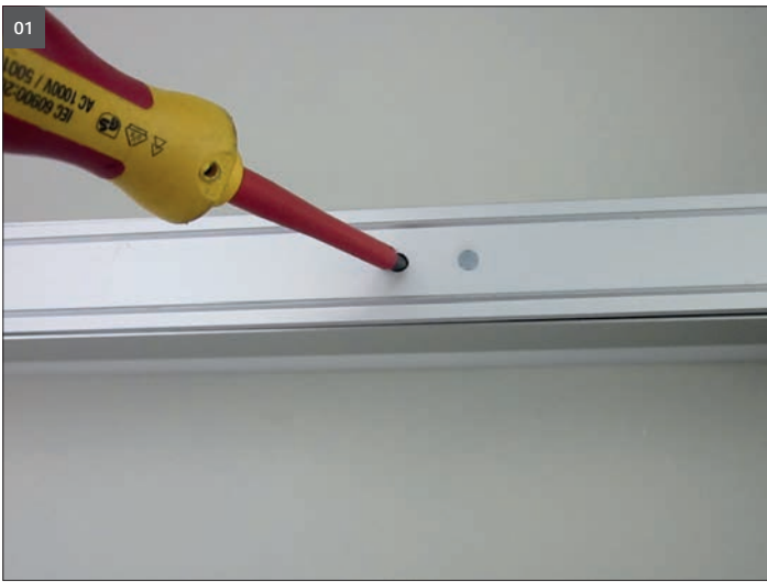
01 Montageplatte mit Schraubendreher vorsichtig herausheben. Die Seitendekel nicht abschrauben!
