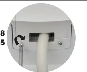
Verbinden Sie nun das Zuleitungskabel entsprechend der elektrischen Vorschriften an der Anschlussklemme L  $\oplus$  N 230V / 50Hz. Zugentlastung anbringen und Abdeckung vom Anschluss schließen.
